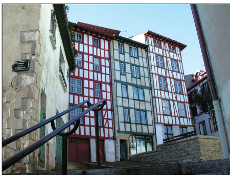
图10 布拉舍特广场街区改善整治后立面 Fig.10 Façade of Plachotte Square after the project
