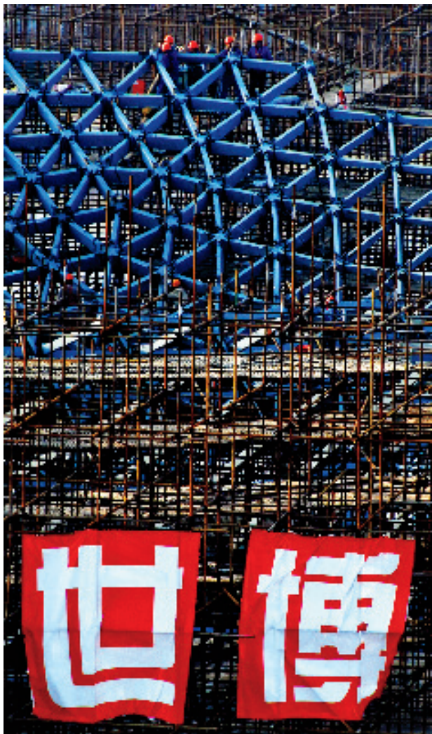
上海世博工地“阳光谷”建设工程正在紧锣密鼓地展开，造型独特的外观初显雏形。
